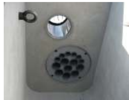
特殊部内から見たボルト固定式ロータス管の取付状況
