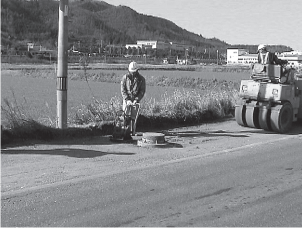
⑦ 防護ふた周り路盤転圧状況
