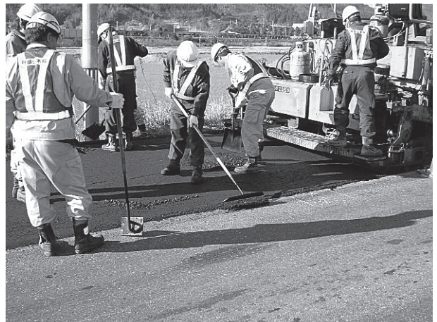
⑭アスコン敷きならし
