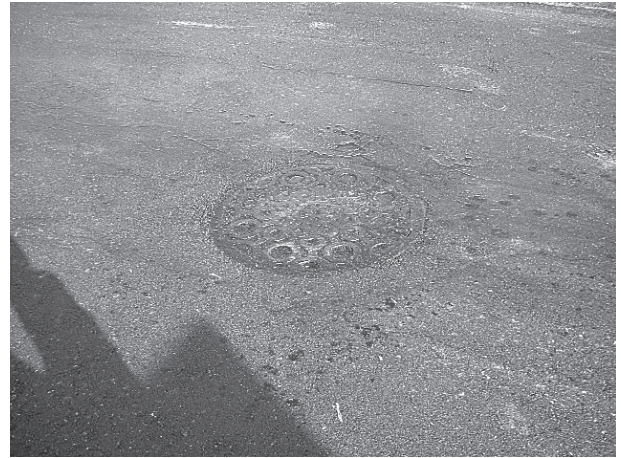
⑱二層目舗装終了時
