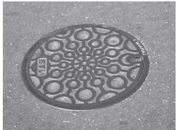
⑳防護ふた周辺状況
