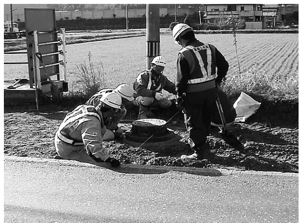
⑥防護ふた設置・完了
