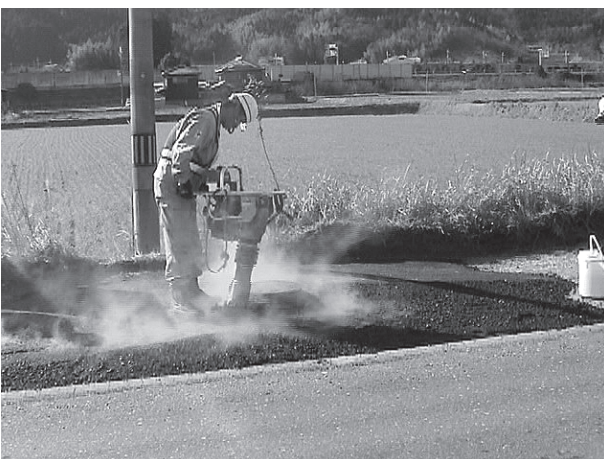
⑩ 防護ふた周辺の転圧状況
