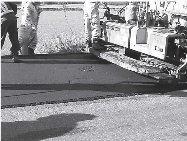
⑬アスファルトフィニッシャー通過直後
