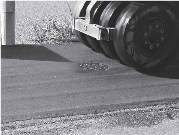
⑰タイヤローラでの転圧
