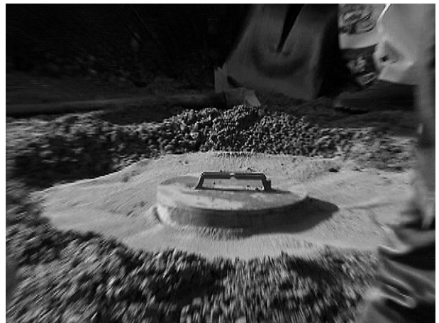
④空練モルタル投入後敷きならし
