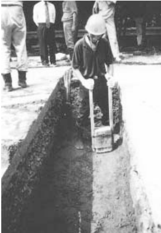
写真4.1 塩ビ管の埋設状況
