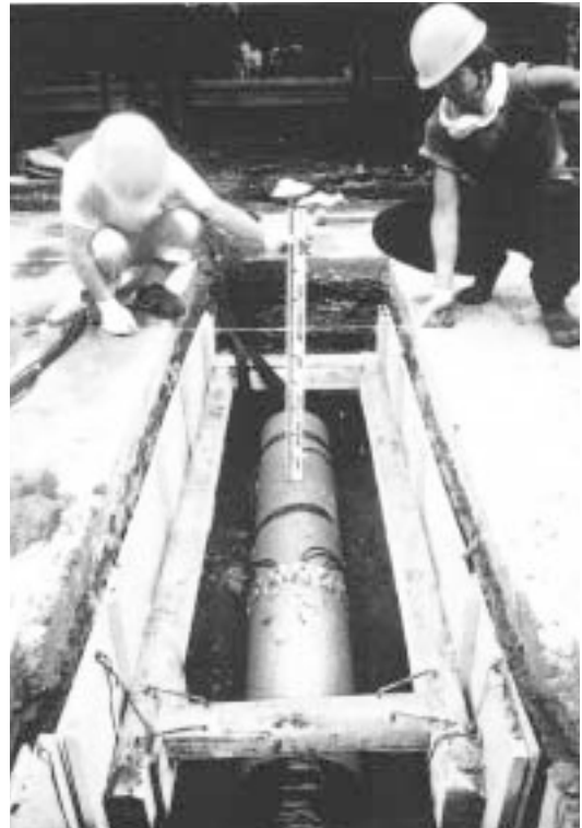
写真4.2 基礎部の埋戻し状況
