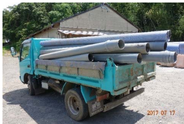
復旧工事業者から直接持ち込まれた塩ビ管
